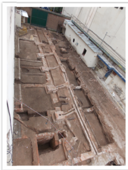
Figura 10: Vista parcial de la Parcela 3 durante el proceso de excavación.
