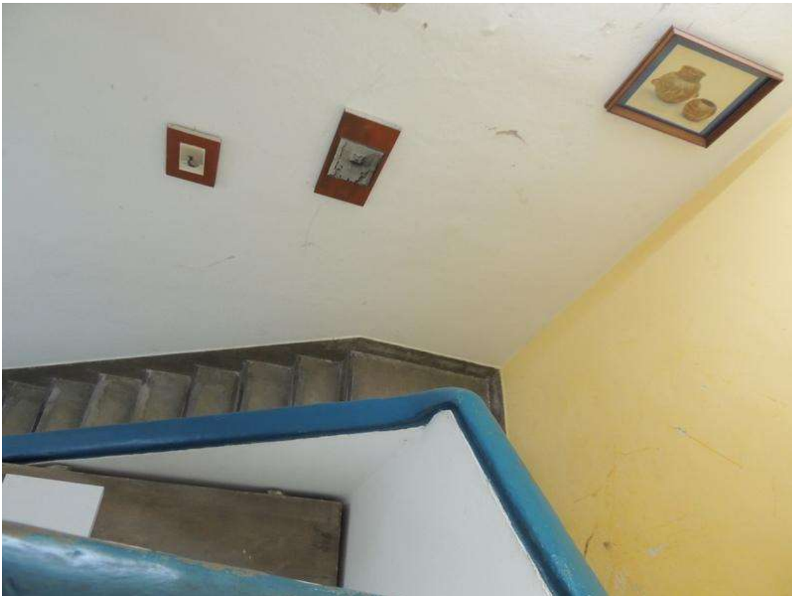
Ilustración 3 Escalera que conduce al subsuelo del Pabellón Argentina donde se encuentran las áreas de reserva del Museo de Antropología
