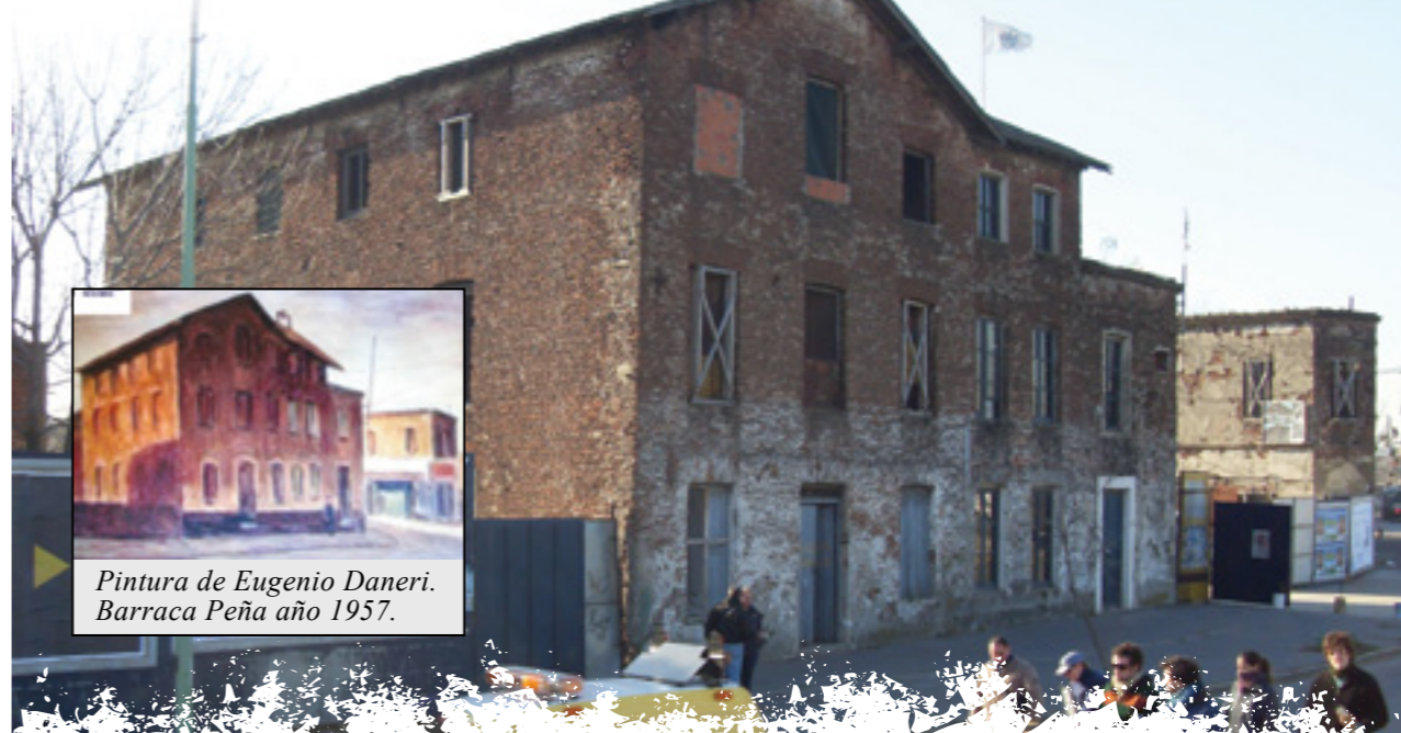
Vista del edificio principal de la Barraca Peña en 2009.
