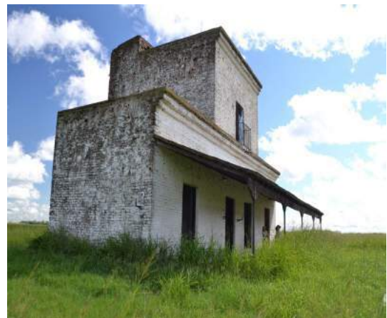
Figura 1. Vista del frente Noreste del Reducto Rural Fortificado.
