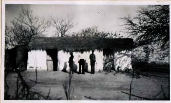
Típico rancho criollo de adobe y techo de pajizo, de dos aguas. Alrededores de Villa del Rosario, Dep. Río Segundo (Córdoba) Morador D. Epifanio Robledo. Octubre de 1947
