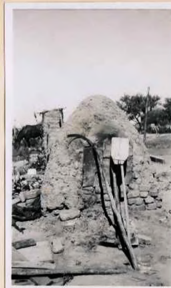
Horno criollo de forma cónica de ladrillo de barro crudo y revestido de barro; pala de madera para sacar el pan (hornear) y horquilla de tronco de tala con punta de hierro (suncho) para revolver las brasas. Del mismo rancho. Octubre de 1947
