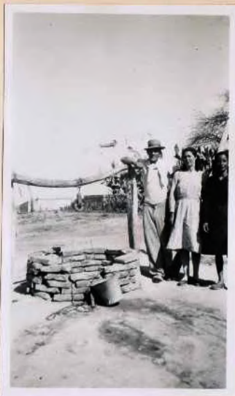
Pozo de agua, criollo, de ladrillo cocido y horcones y travesaño de madera de algarrobo y roldana de madera de algarrobo y soporte de hierro. Alrededores de Villa del Rosario, Dep. Río Segundo (Córdoba) del rancho de D. Jesús Arguello. Octubre de 1947
