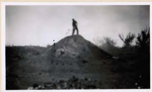
Horno de tierra, encendido. Obraje Las Achiras. Los Hoyos (dep. Río Seco) Córdoba. Diciembre de 1947.
