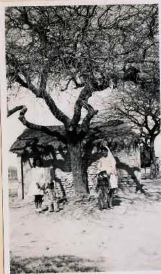
Ranchito criollo de ladrillos de barro crudo, adobe, y techo de pajizo, de dos aguas, a la sombra de un algarrobo. Alrededores de Villa del Rosario, Dep. Río Segundo (Córdoba). Morador D. Jesús Arguello. Octubre de 1947
