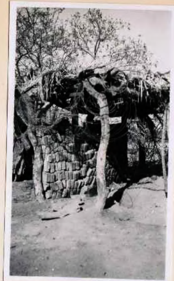
Ramada criollo de troncos de algarrobo, ladrillos cocidos y techo de caña cañaveral y palma. Alrededores de Villa del Rosario, Dep. Río Segundo (Córdoba). Del rancho de D. Jesús Arguello. Octubre de 1947.
